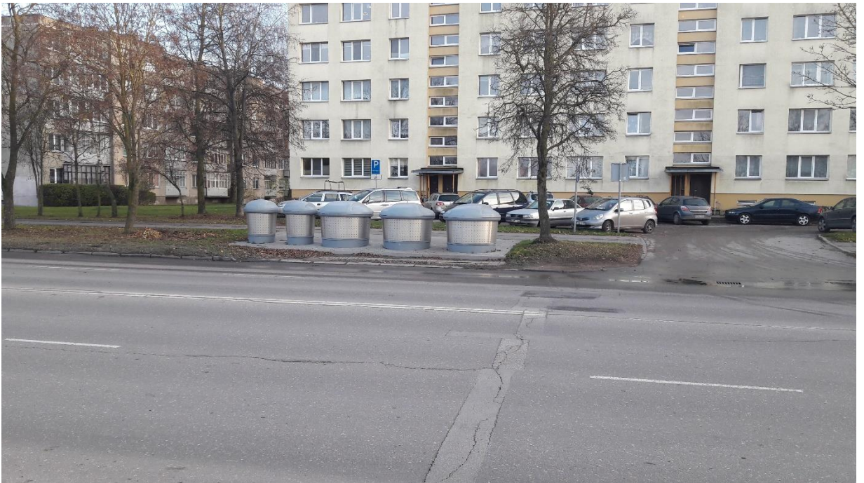
1.3 pav. Pažeisti lopai Putinų gatvės ruože
