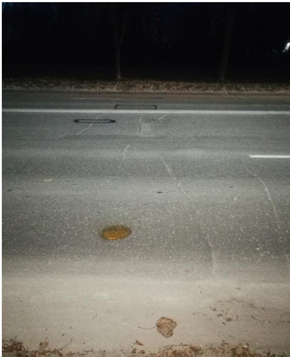
1.4 pav. Skersiniai plyšiai Putinų gatvės ruože
